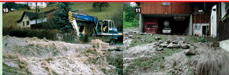
der Gemeinde Grabs. Bild 11: Kurze, heftige Sommergewitter lassen auch kleine unscheinbare Bäche schnell anschwellen und über die Ufer treten. Das Unwetter im Juli 2003 verursachte in der Gemeinde Grabs alleine an Einrichtungen der Infrastruktur Schäden in Höhe von über 500000 Fr.
